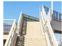
WORKS #4 清水交差点 (北九州市)
