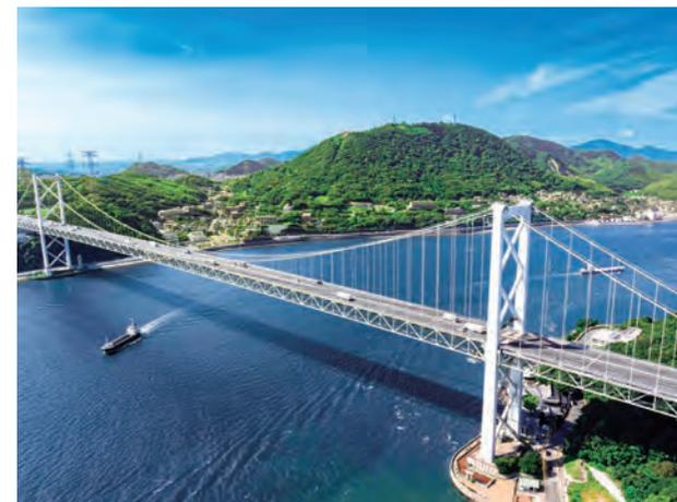
1973（昭和48）年11月に開通した関門橋においては、約40年経過後から10年以上の長期にわたるリフレッシュ工事を実施中。弊社は当工事に継続的に携わっており、これまでに縦桁補強・検査路・支承取替のほか、主ケーブル送気設備の設置に必要な部材、バンドボルト・ハンドロープの交換のための部材を納入しました。
