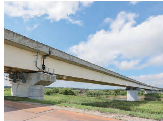
耐震性向上を図るため、道東自動車道の「新千歳川橋」他2橋の耐震補強工事を実施。約3年間にわたる工事において、弊社では、平岡橋、上長都橋、新千歳川橋へ横変位拘束構造・水平力分担構造・落橋防止構造等の耐震補強工事に必要な部材を製作、納入しました。
