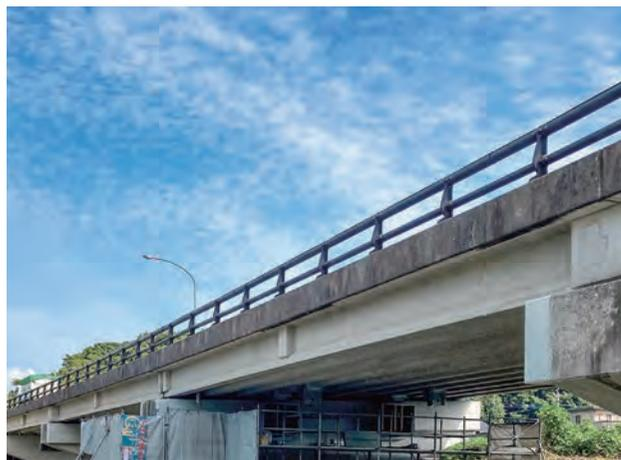
行橋市内にある道場寺橋は、地域の方々の生活に必要不可欠な橋。日々安全に利用していただくために、水平力分担構造・落橋防止構造等の耐震補強工事に必要な部材を製作、納入しました。
