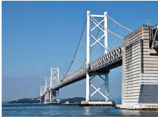
道路・鉄道併用橋である「瀬戸大橋」の耐震性向上を図るため、吊橋、斜張橋、トラス橋及び高架橋の耐震補強工事を実施。2年間にわたり下津井瀬戸大橋、南備讃瀬戸大橋、北備讃瀬戸大橋、番の州高架橋、岩黒島橋、櫃石島橋6橋の支承補強・支承補完・横構補強工事に必要な部材を製作、納入しました。
